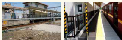
① 養老鉄道ホーム延伸遠景 ② 養老鉄道ホーム延伸
