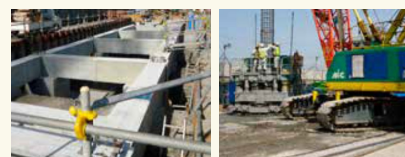
⑤ 地中梁（脱型後） ⑥ 杭工事
