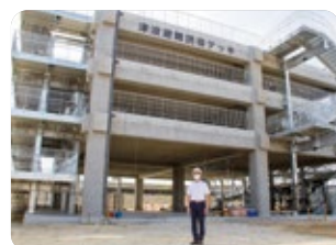
津波避難誘導デッキは3階建てで、屋上にも上がれます。
