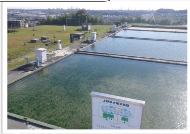
上野浄水場緩速ろ過池
