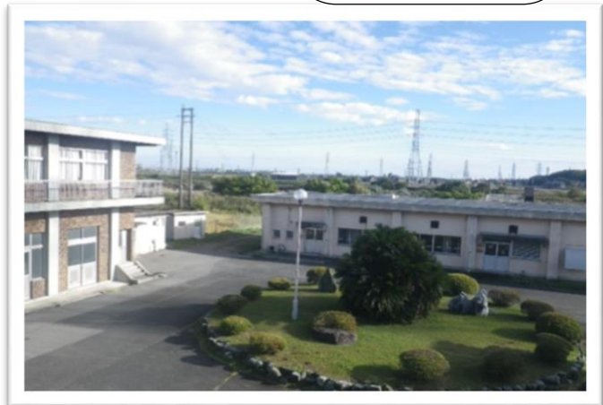
町屋水源地管理棟
